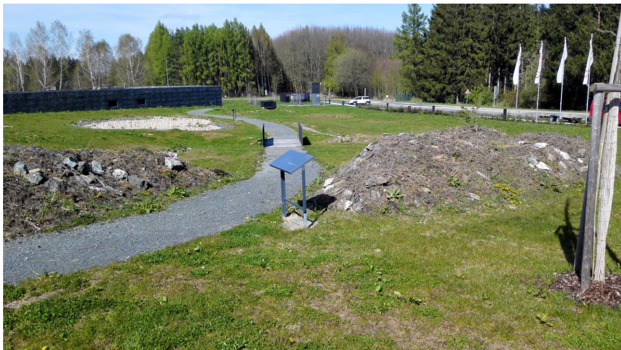
Obrázek 33: Budování hadcových skalek v areálu Vodního domu (stav květen 2017).
