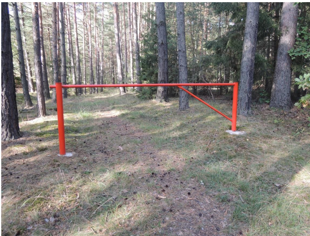
Obrázek 5: Instalovaná závora na příjezdové cestě k oblasti B1
